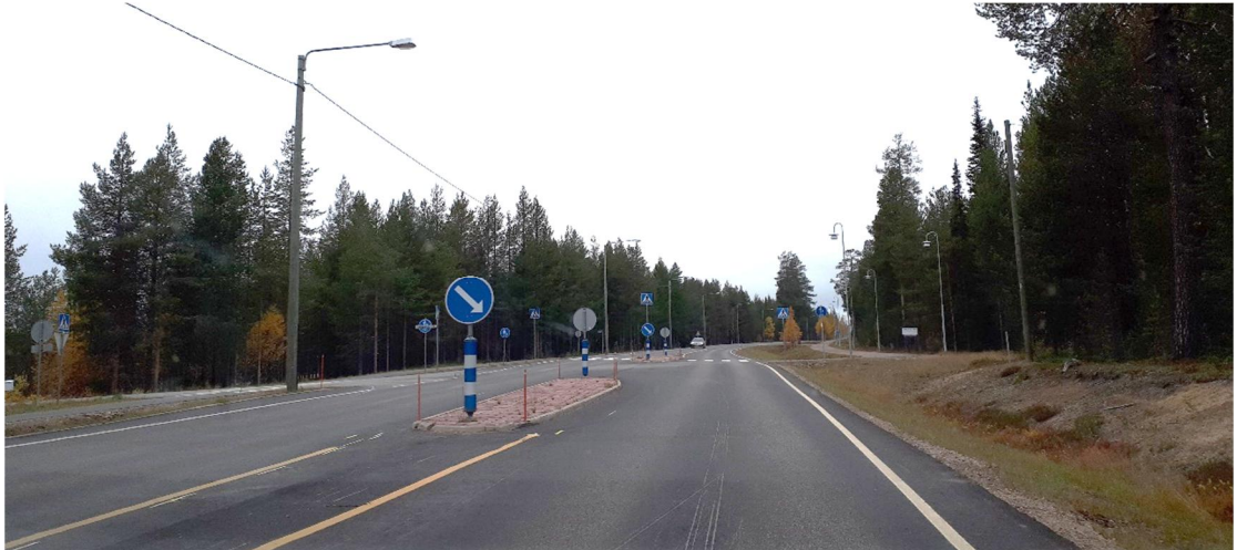
Kuva 42. Suojatiesaareke lisää suojatien näkyvyyttä.
