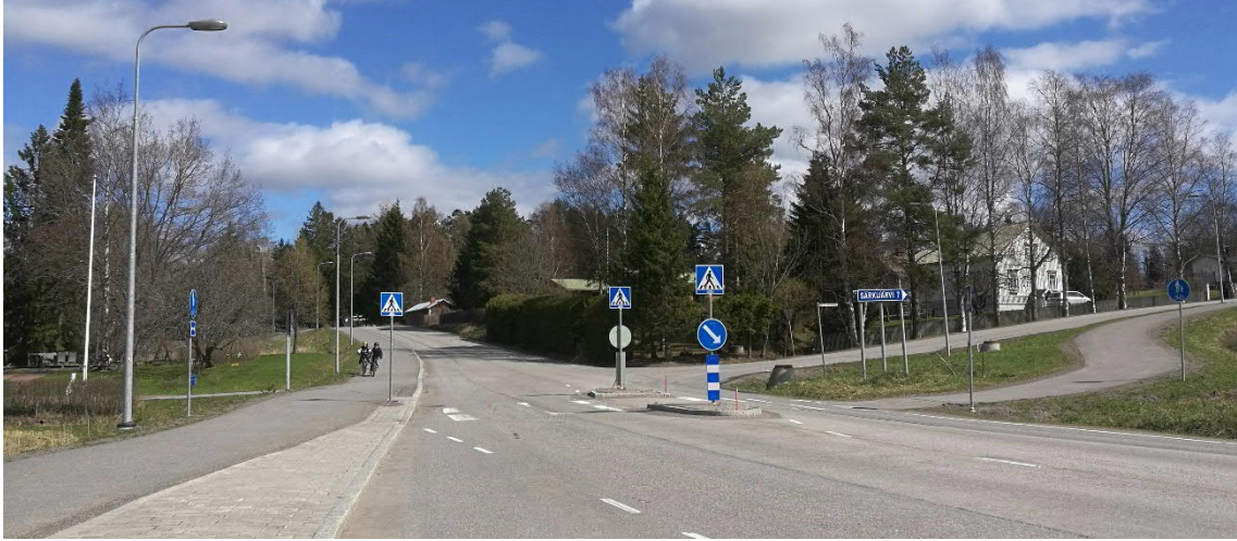
Kuva 6. Askolantie x Sorvasuontien suojatie tarvitsee uudelleen maalaamista sekä puuttuvien herätevarsien lisäämistä. Taustalla oikealla näkyy tuija-aita, joka haittaa näkemää Sorvasuontieltä Askolantielle liityttäessä (toimenpide 13.).
