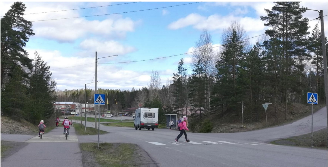
Kuva 5. Askolantie x Mäntyrinteentien sekä Askolantie x Pappilantien liittymien suojatiet, joissa on suojatiemerkki ja herätevarsi puutteita sekä tarvetta suojatien uudelleen maalaamiselle (toimenpiteet 9. ja 10.).
