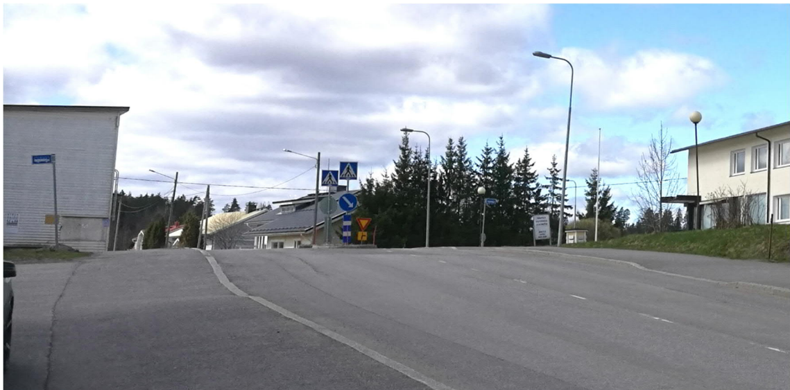
Kuva 7. Askolantie x Siltatien suojatieltä puuttuvat uloimmat suojatiemerkit herätevarsineen.
