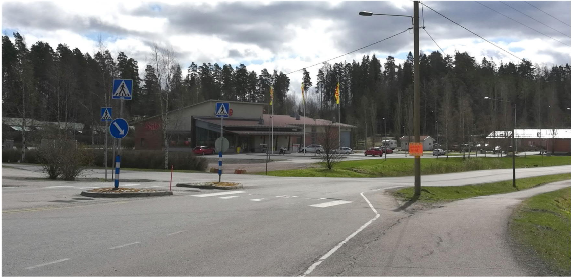
Kuva 4. Askolantien apteekin kohdan suojatienäkymä. Rikkoutunut asfaltti jalankulku- ja pyörävälille tullessa on aiheuttanut painauman, joka hankaloittaa liikkumista. Oikealta puuttuu suojatiemerkki ja vasemmanpuoleisesta suojatiemerkestä puuttuu herätevarsi (toimenpide 7.).
