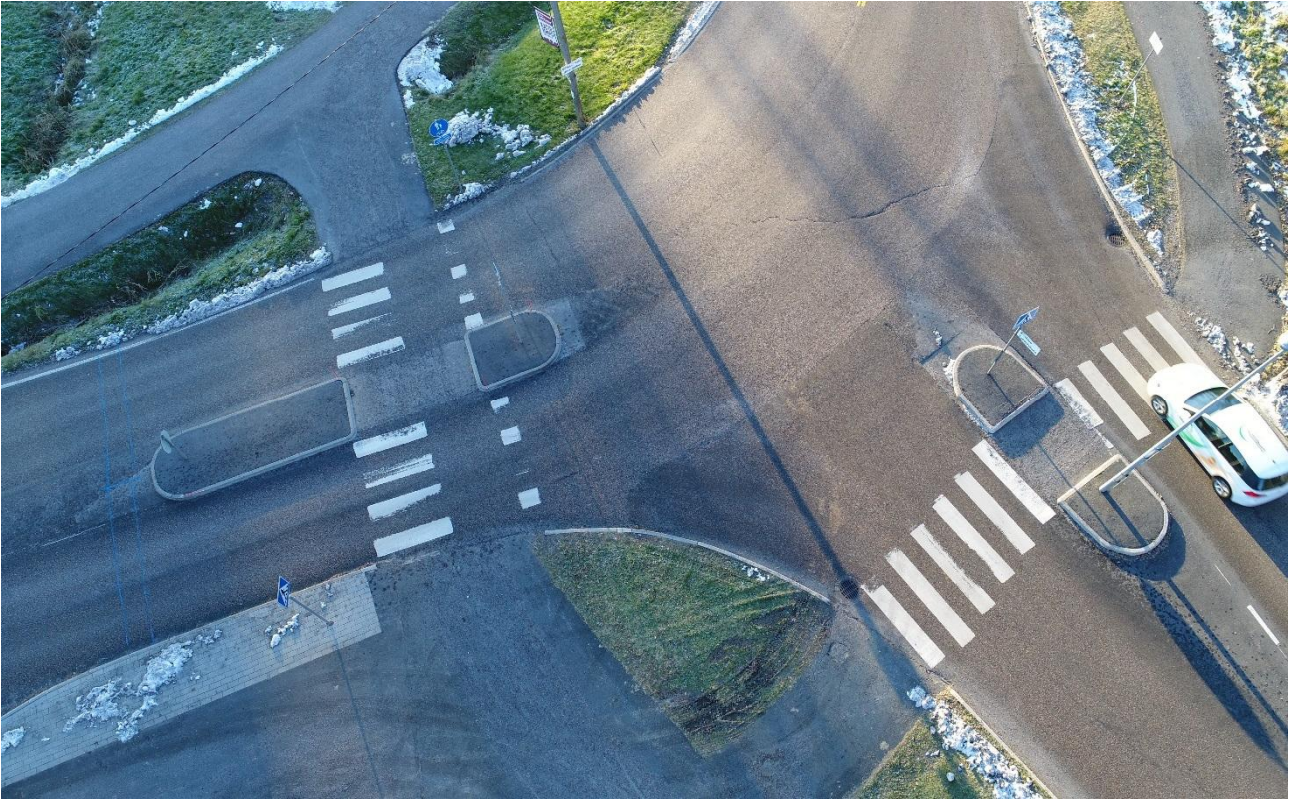
Kuva 4. Nöykkiönkadun suojatie ennen älykkään suojatievalaistuksen asentamista (vasemmanpuoleinen suojatie).
