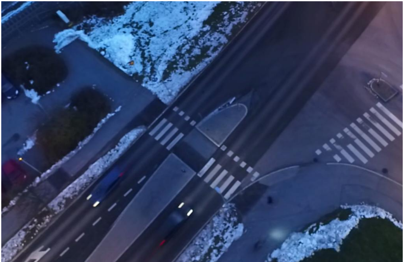
Kuva 7. Tuomarilantien suojatie ennen älykkään suojatievalaistuksen asentamista (vasemmanpuoleinen suojatie).
