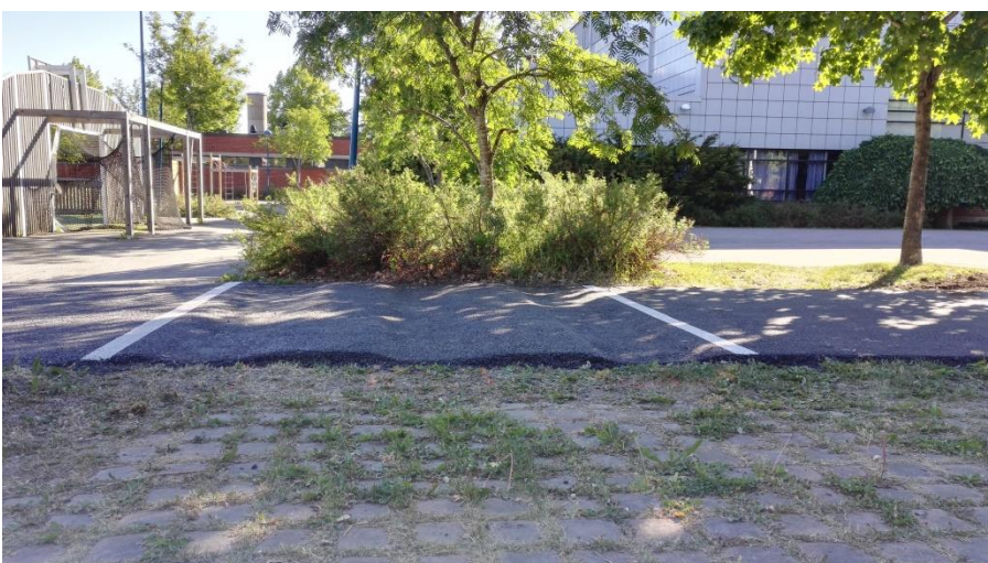
Kuva: Hidaste mitoituksella 500-500-40
