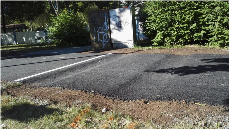
Kuva: Hidaste mitoituksella 1000-500-50
