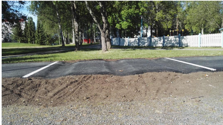
Kuva: Hidaste mitoituksella 1000-500-80
