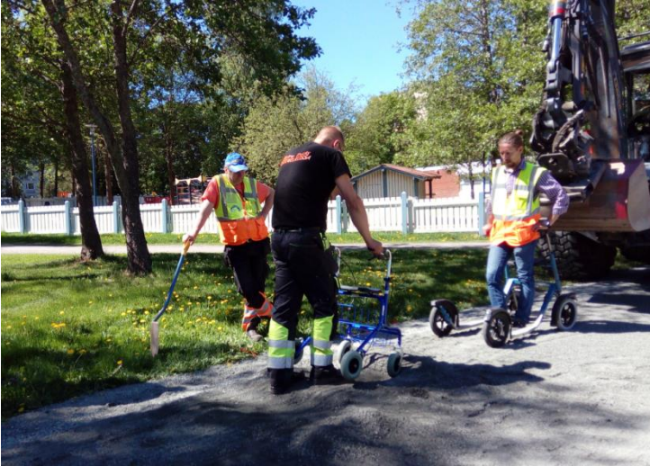
Kuva: Rakennusvaiheen välinetestauksia
