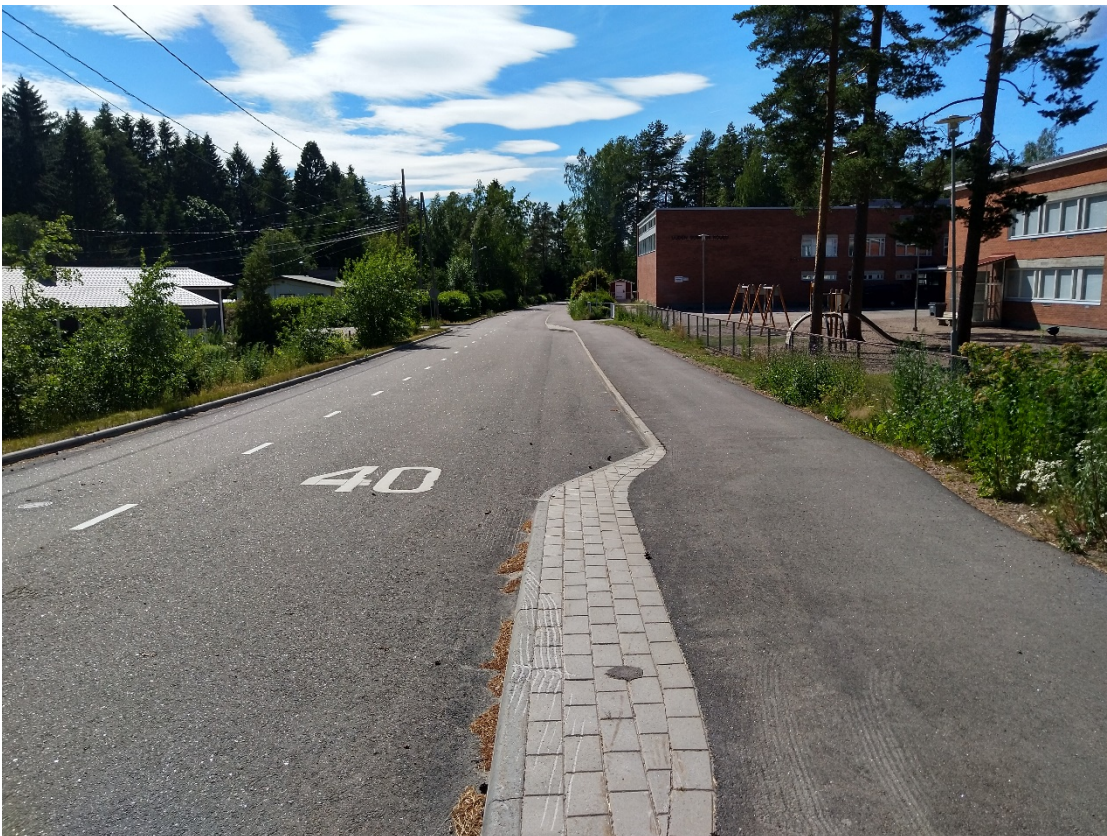
Kuva 1. Rakennettu levike saattoliikenteelle (kuva: Jukka Hietapakka).
