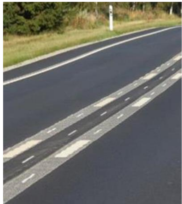
Kuva 56. Leveä keskialue toteutetaan maalauksin ja jyrksinnöin (kuvan mitoitus ja ratkaisu on vanhentunut, vrt. kuva 57).
